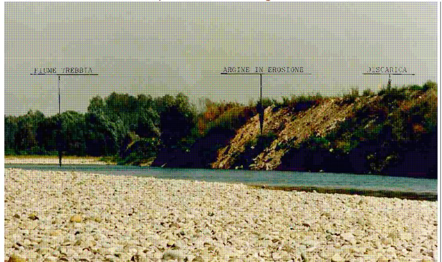
Collocata in un'area **sensibile**, naturalmente esposta ad erosione fluviale, la sponda destra occupata dalla discarica ha subito negli anni diversi lavori di **difesa idraulica** e consolidamento necessari per scongiurare il rischio di caduta della scarpata con relativo trascinarsi dei rifiuti a valle e per mitigare ripercussioni idrauliche in sponda sinistra del fiume Trebbia.
