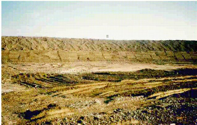
Avvallamenti del suolo e infiltrazioni di acque meteoriche all'interno della massa dei rifiuti possono favorire poi la produzione di **percolato**, un refluo contaminato da sostanze inquinanti derivanti dal degrado biologico, chimico e fisico dei rifiuti. Questi, infatti, a seconda del materiale di cui sono fatti si degraderanno in tempi più o meno lunghi.
