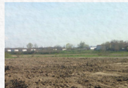
Collocamento suoli ricostituiti nell'area di intervento dell'Azoto.
